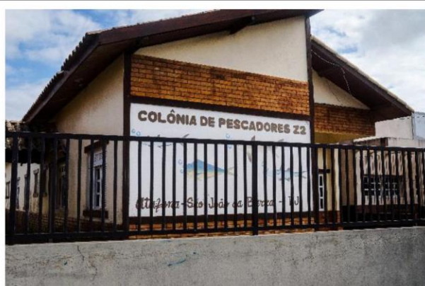
Sede da Colônia de Pescadores Z2 Deisemara Barreto São João da Barra – Atafona
