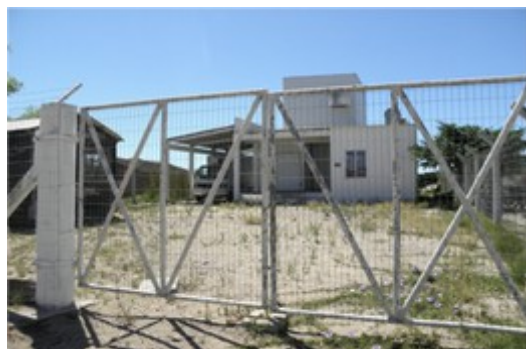
Figura 6 – Prédio da fabrica de gelo
